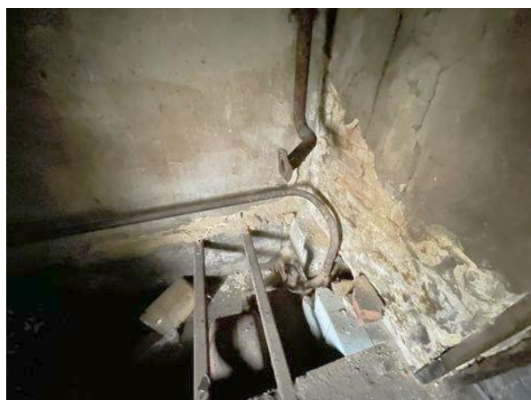
odstraněný kotel ÚT
