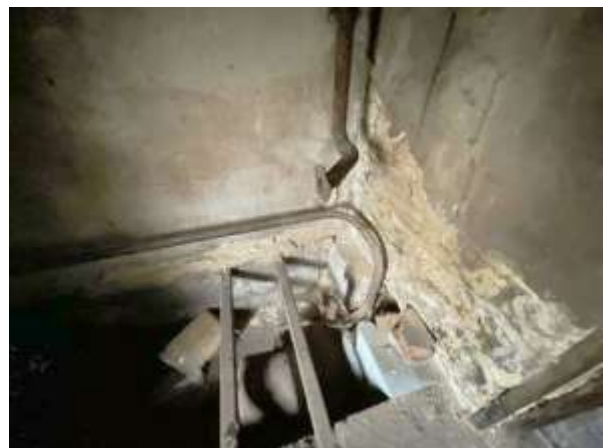
odstraněný kotel ÚT
